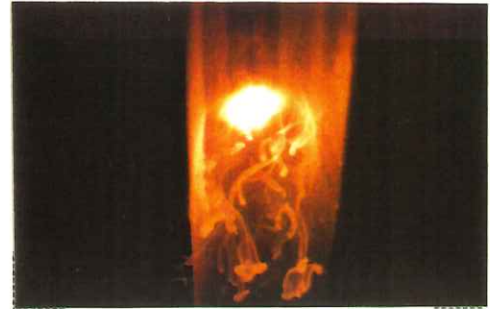
(b) 裏波溶接状況
